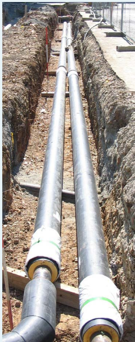
Abbildung: Fernwärmeleitung in der Bauphase (Tübingen),
